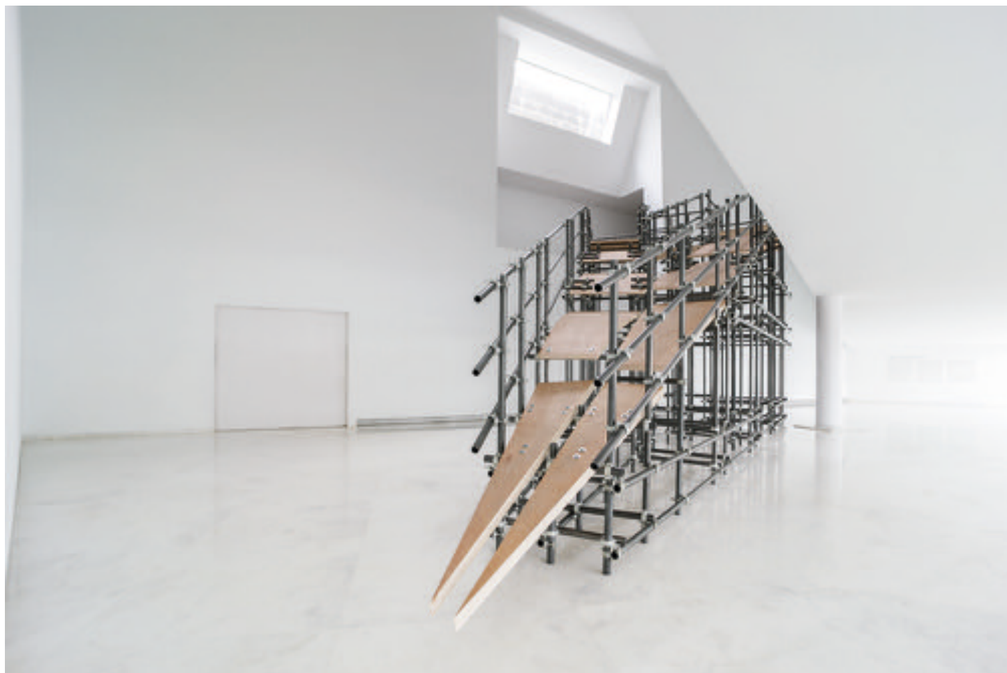
Proceso de inicio 2017 | Pipes and scaffolding clamps
